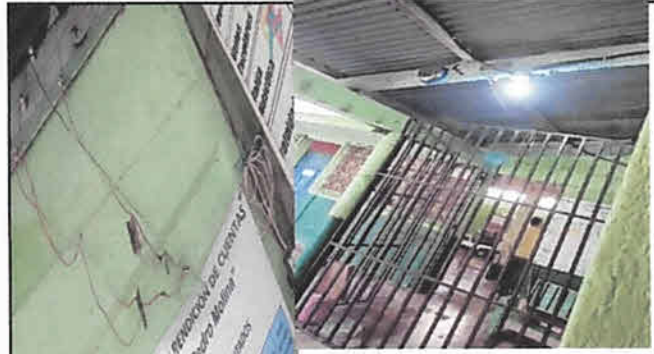
Foto 4: DIRECCIÓN: Instalación del sistema eléctrico.
