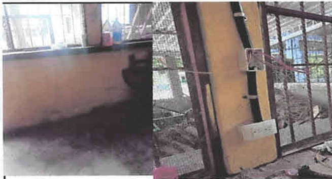
Foto 3: Fabricación de meson de concreto.
