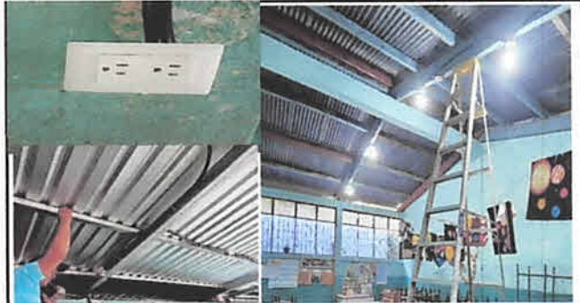
Foto 6: AULAS: Instalación del sistema eléctrico.
