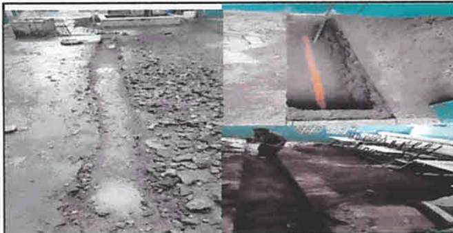
Foto 5: PATIO: colocación de la tubería para drenajes pluviales.
