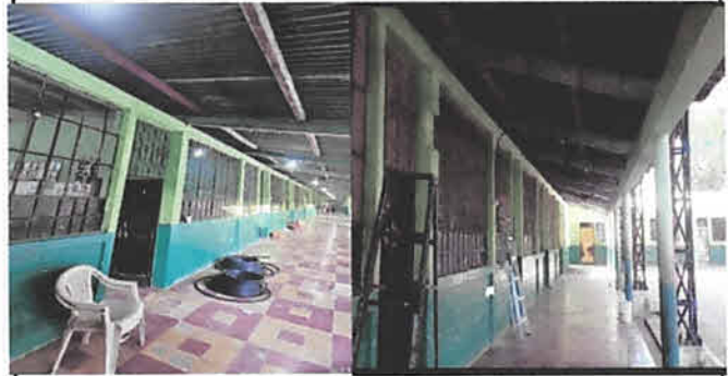
Foto 2: Instalación de sistema eléctrico
