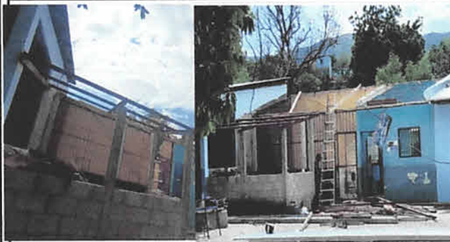
Foto 1: COCINA: Puesta de costanera y enlaminado
